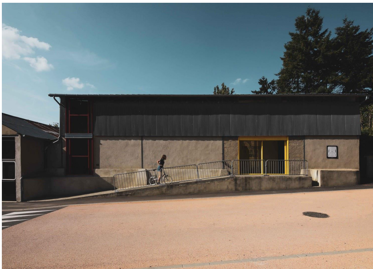
Vue de l'espace Bézard - Le Corbusier
