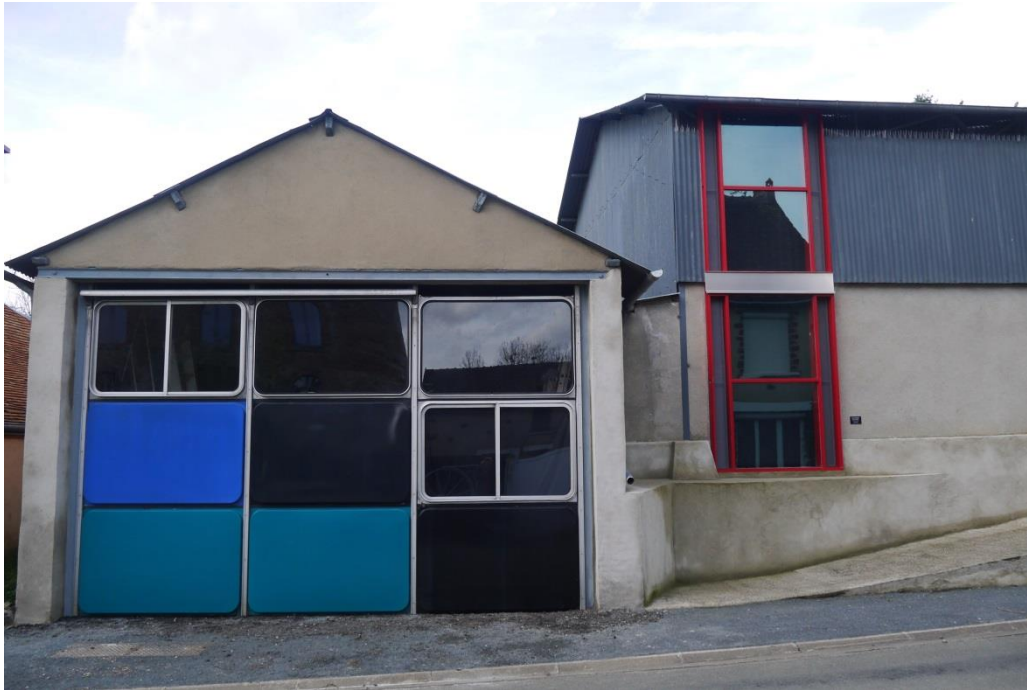
Jean Prouvé, avec la contribution d'Ibaï Hernandorena Panneaux de façade provenant du bâtiment scolaire André Argouges de Grenoble, 1965. A droite de la photo : baie archive Le Corbusier de l'aérodrome Le Corbusier/Prouvé de Doncourt-lès-Conflans, 1954.
